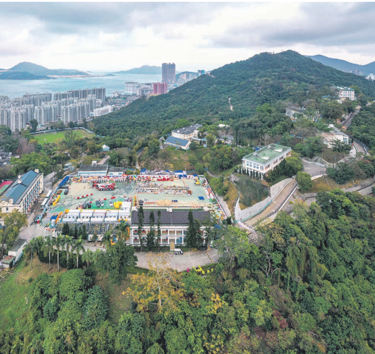
construction à Hong Kong.
