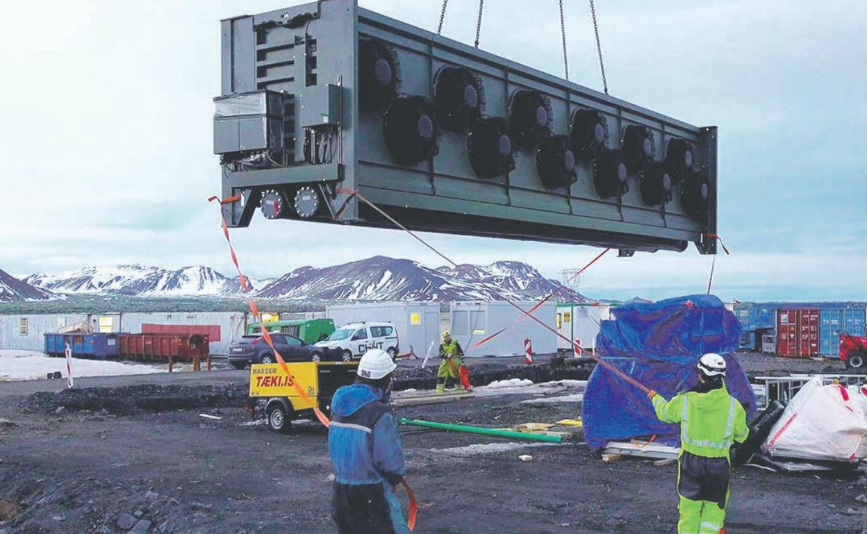
Installation d'une station de capture-enfouissement de CO<sub>2</sub> de l'entreprise suisse Climeworks en Islande. Elle permettra de retirer 4000 tonnes de CO<sub>2</sub> de l'atmosphère par année, l'équivalent de la production de... 285 habitant.e-s de la Suisse.
